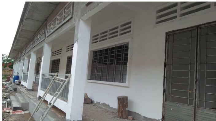
Nouveau bâtiment à Svay-Prey
